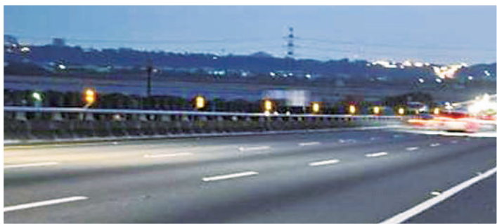
加強國1三義南下長陡坡路段交通設施、提升行車安全
