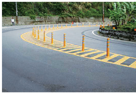
台 9 線 32K+700 改繪槽化線 並加設交通桿（回復式導桿）
