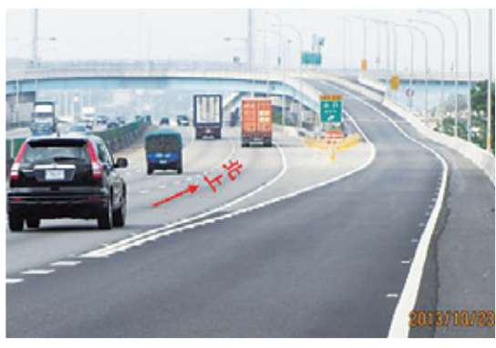
國 1 北上銅鑼交流道（140k+600 公尺處）事故路段改善
