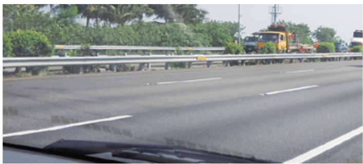
國1南下292k內側護欄加設反光浪板
