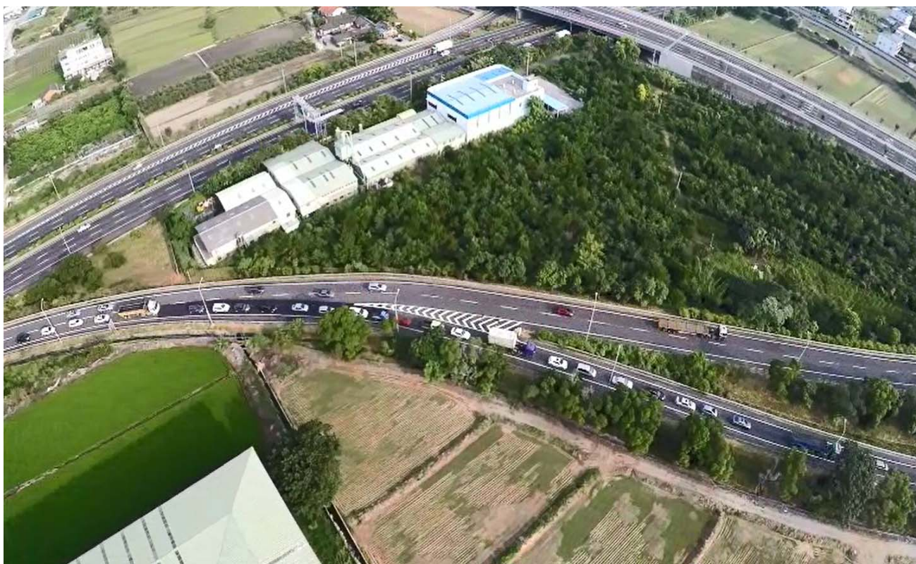
圖 1 改善前后里匝道車輛停等長度情形(拍攝日期:106.09.25)
