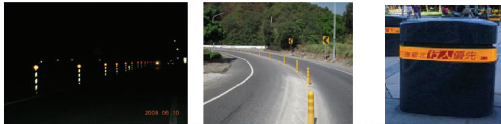
圖 4-3 農路反光導標、彎道分隔交通桿及行人車阻反光標識
